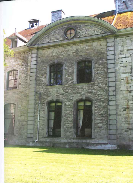
▲ ILL. 12 – Het centrale deel van de noordelijke gevel met zijn fronton, toestand van 2019 (foto F.-E. de Wasseige).
