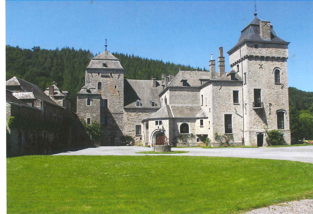
ILL. 13 – De zuidkant, toestand van 2019. Van l. naar r.: de bijgebouwen; de zuidwestelijke toren en de oude slottoren; het gedeelte dat in 1897 door Demany werd gecreëerd (foto F.-E. de Wasseige).
