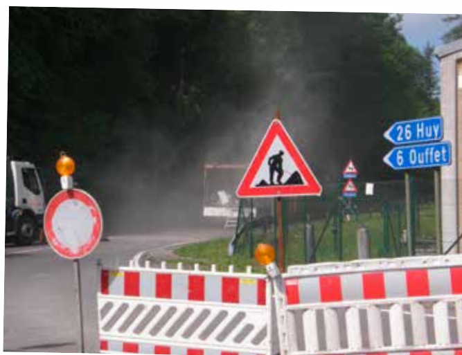
Le SPW rénove le revêtement de la route Hamoir-Ouffet
