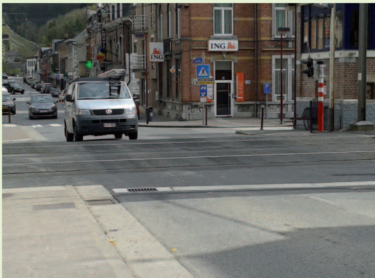
Réaménagement du passage à niveau à Hamoir. Enfin !
