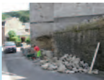
Reconstruction du mur de soutènement de l'église de Fairon.
