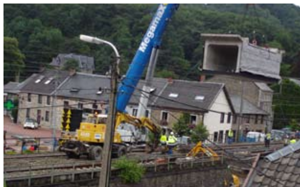
Aménagement du passage sous voies à Comblain-la-Tour (photo SNCB)
